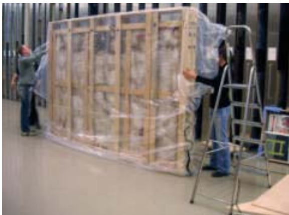
Abb. 55: Überziehen des Foliensacks.
