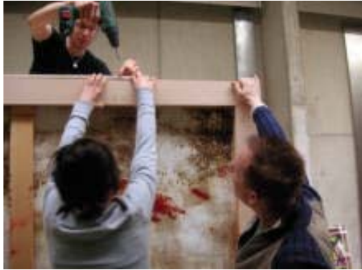
Abb. 38: Montage der Sperrholzbretter.
